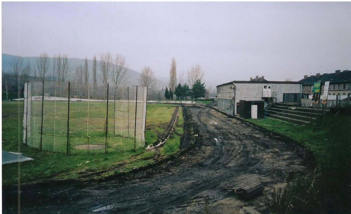
Obr. 39 Atletický štadión Mladá garda pri začatí jeho rekonštrukcie v roku 2004
